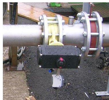
Figure 4: valvola di sicurezza on/off installata sulla linea principale
