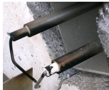
Figure 7: elettrodi accenditori fotografati dall'interno del bruciatore nella zona di produzione dell'arco
