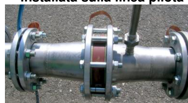
Figure 6: filtro rompifiamma a protezione delle sezioni impiantistiche a monte
