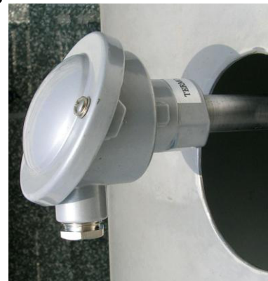
Figure 10: termocoppia per rilevamento temperatura fiamma
