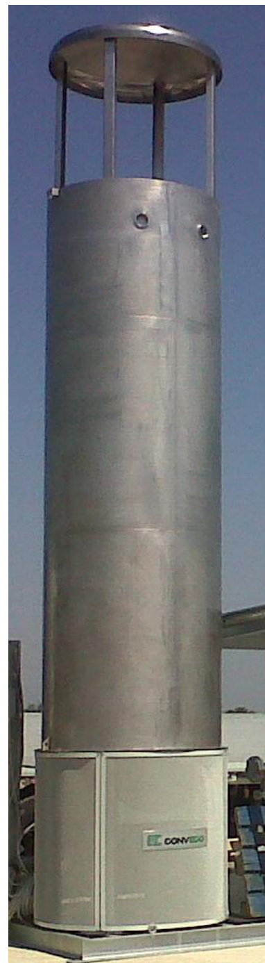
Figure 3: torcia di combustione biogas posizionata su platea
