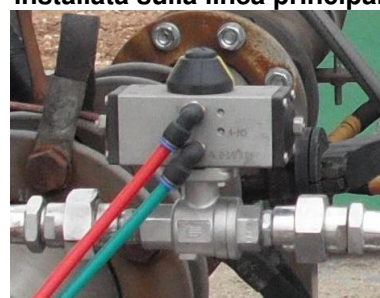
Figure 5: valvola di sicurezza on/off installata sulla linea pilota
